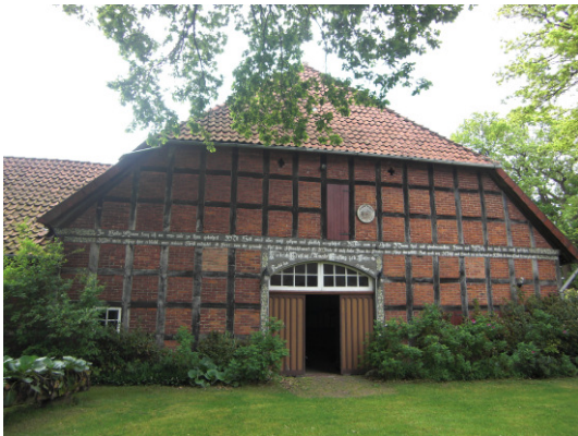
Abb. 26: Wohnwirtschaftsgebäude in Fachwerk (Borstel)
