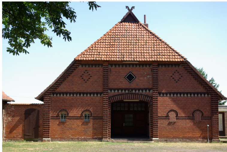
Abb. 28: Das Fachwerkgebäude erhielt um 1900 eine reich verzierte Ziegelfassade (Nöpke)
